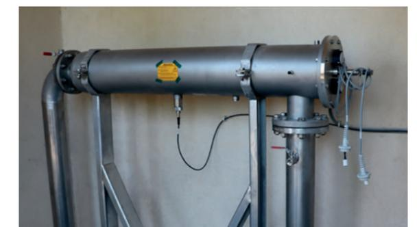
court. La lumière, émise par la lampe, est calée sur une longueur d'onde spéciale de 254 nm. Nous connaissons tous les UV A et B, mais les lampes en question sont classées dans les UV C. Quasiment aucun micro-organisme pathogène ne résiste au passage dans la chambre.
